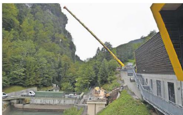
Die Stauwehrmauer mit dem Baukran, von der Stoosbahn aus gesehen.
