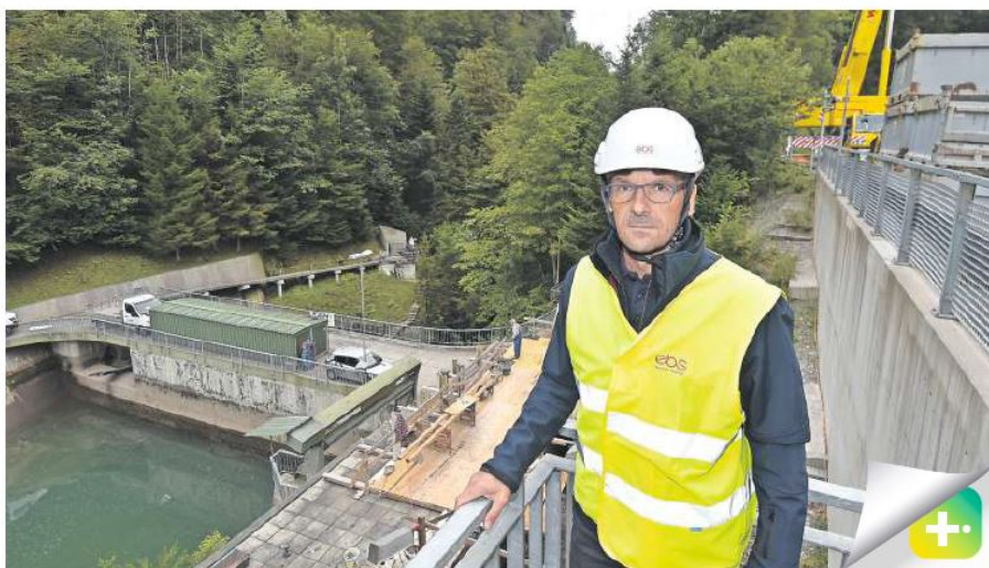
Theo Baumann von der ebs Energie AG informiert gestern zum Beginn der Bauarbeiten.
