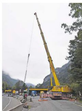
Mit dem Baukran wurden alte Bauteile an die Kantonsstrasse gehievt.
