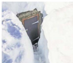
Beim Restaurant Glattalp musste ein meterhoher Durchgang zum Vorratskeller geschauft werden.
