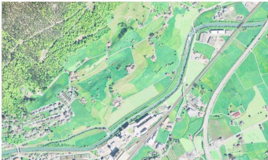
Der Kanal, der parallel zur Muota läuft, wird aufgefüllt, die Muota rechtsufrig aufgeweitet. Mitte unten die bisherige Zentrale, links der Unterlauf, rechts der Oberlauf. Bild: weggis
